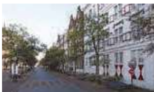
雨水が浸透しやすいレンガ舗装
