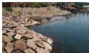
石積みの護岸が守る生態系
