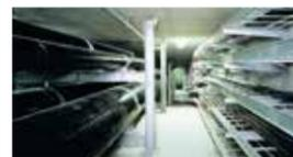
敷設しているインフラ：冷房・暖房・給湯、上水・中水・下水、電力、電話・情報配線など
